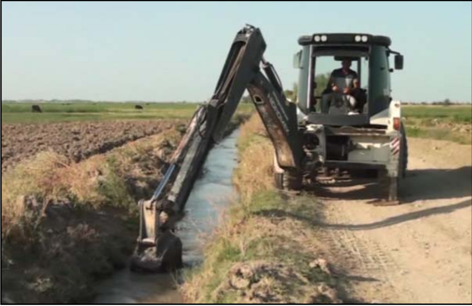
Ağdamda mexaniki üsulla suvarma davam edir, rayonda 10 ədəd subartezian quyusu qazılır.
